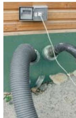
Abb. 12: Befüllstutzen mit Pumpschlauch (rechts), Absaugschlauch und Steckdose für das Absauggebläse
